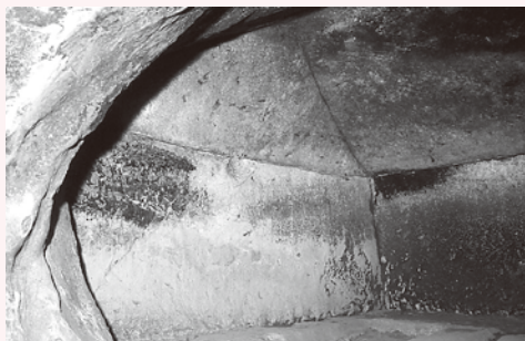
家屋の屋根を模した横穴墓の天井(米満5号墓)。横穴墓の内部はこのような装飾を施したのもも多く、適度に硬いが加工もしやすい岩盤は、その構築に適していた。
